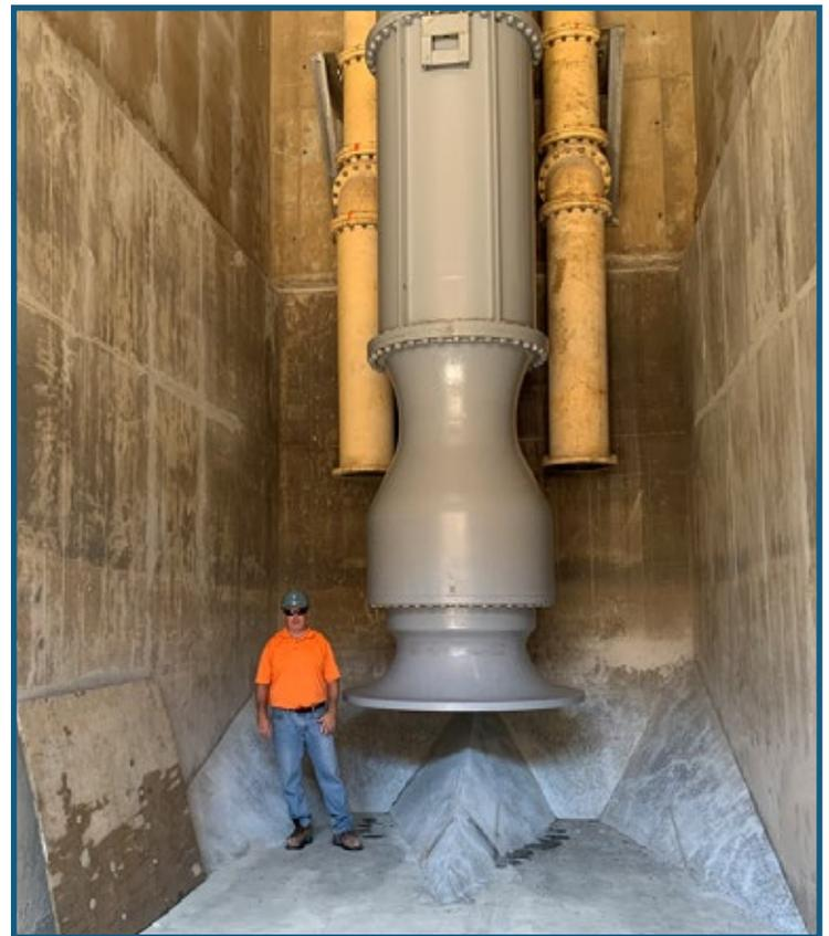
*Se muestra en la foto de arriba es una columna de bomba con una campana de succión en la parte inferior. Las líneas de bronceado en el lado son un sistema de descarga para volver a suspender cualquier sedimento que se acumula en la bahía. - Junto a la columna está David Miller, director de proyectos de Luce Bayou.*
