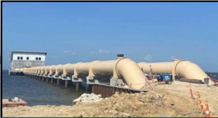
La estación de bombeo está conectada por un puente con tuberías dobles de agua cruda de 108" que corren a cada lado del puente.
