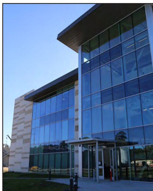
Nuevo edificio de administración/operaciones
