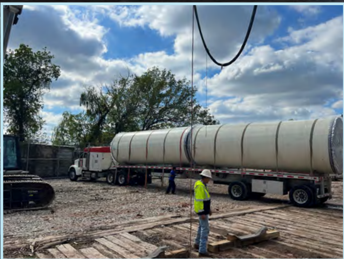
B3 - Entregas de tubos de acero
