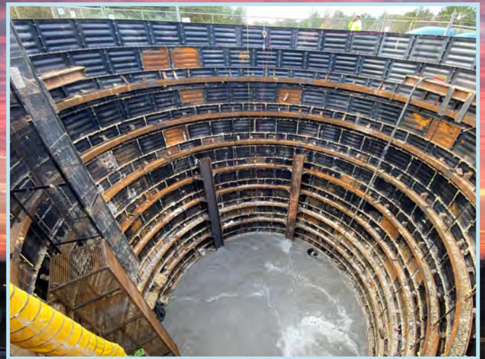
A1-A2 - Curado de la losa de sello en el pozo de entrega de los ductos SE
