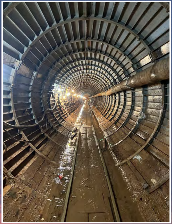
B1-B2 White Oak Bayou - Túnel completo
