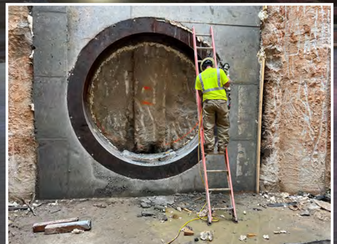
C1 - Ojo del túnel en Bear Creek
